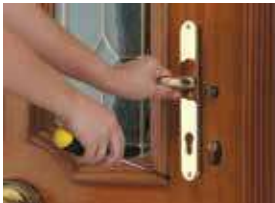
A. Remove lever plate.
